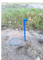
Regard de branchement eau potable (projet)
