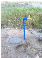
Regard de branchement eau potable (projet)
