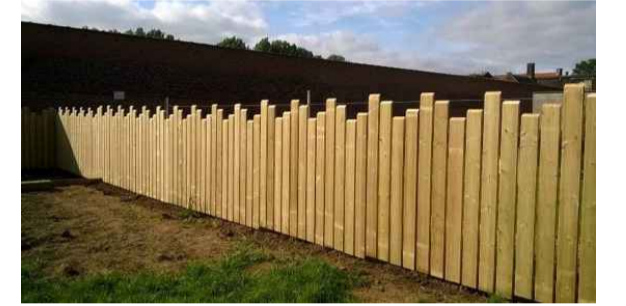
Dispositif à claire voie : Clôture bois à lames verticales
