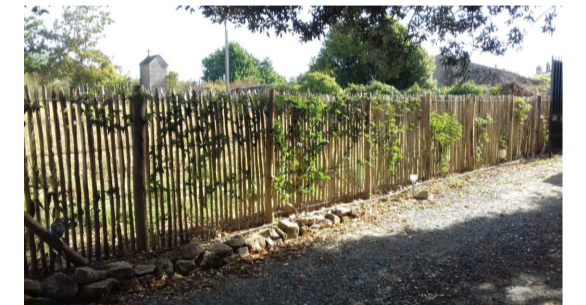
Dispositif à claire voie : Ganivelle de châtaignier
