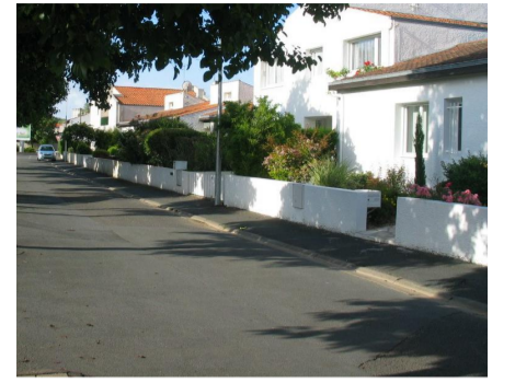
Muret en maçonnerie enduit deux faces
