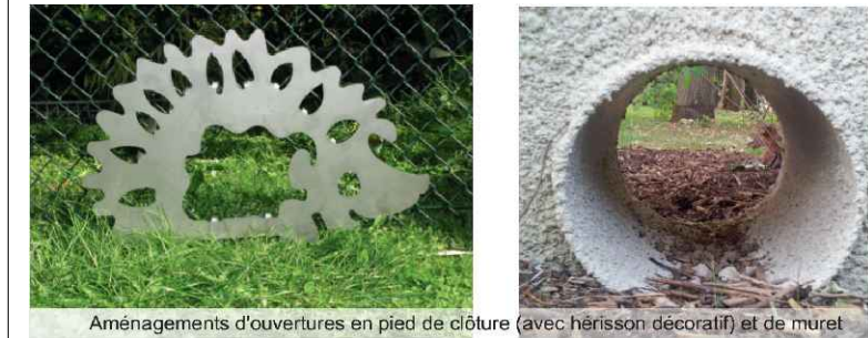
Aménagements d'ouvertures en pied de clôture (avec hârisson décoratif) et de muret
